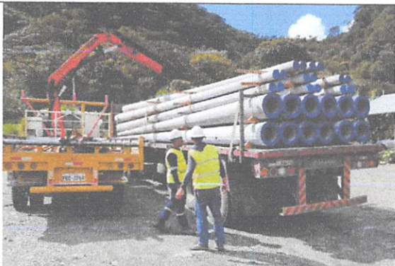
Descarga de postes
