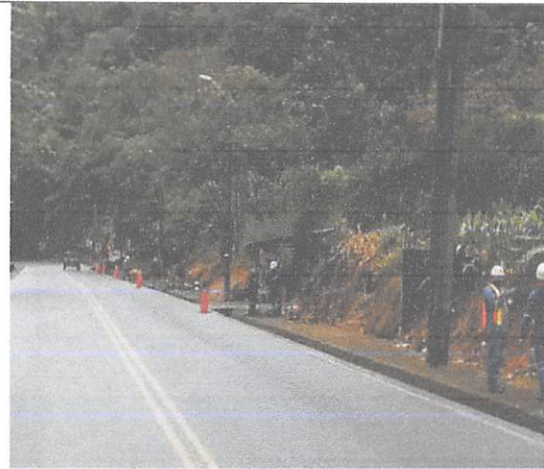
Señalización con conos en la via
