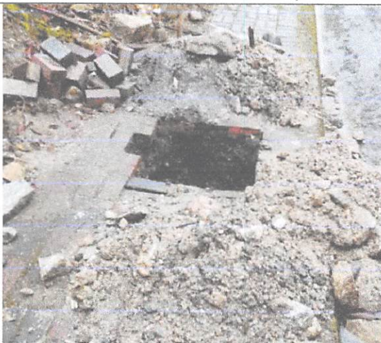
Excavación para postes
