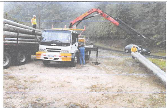
Colocación de postes en sitio
