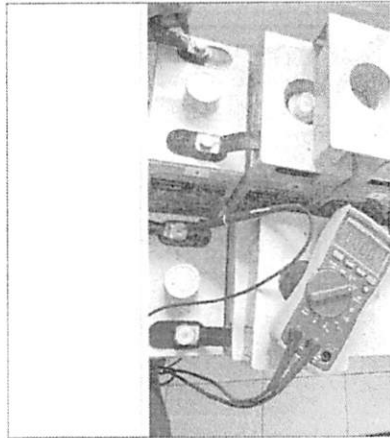
Fotografía 1. Banco de baterías descargado S/E Puyo 1.
